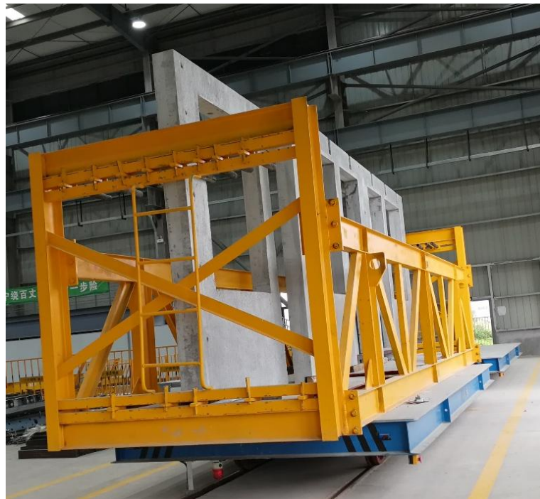
图 4-4-2 采用运输架的竖向构件正确运输方式
