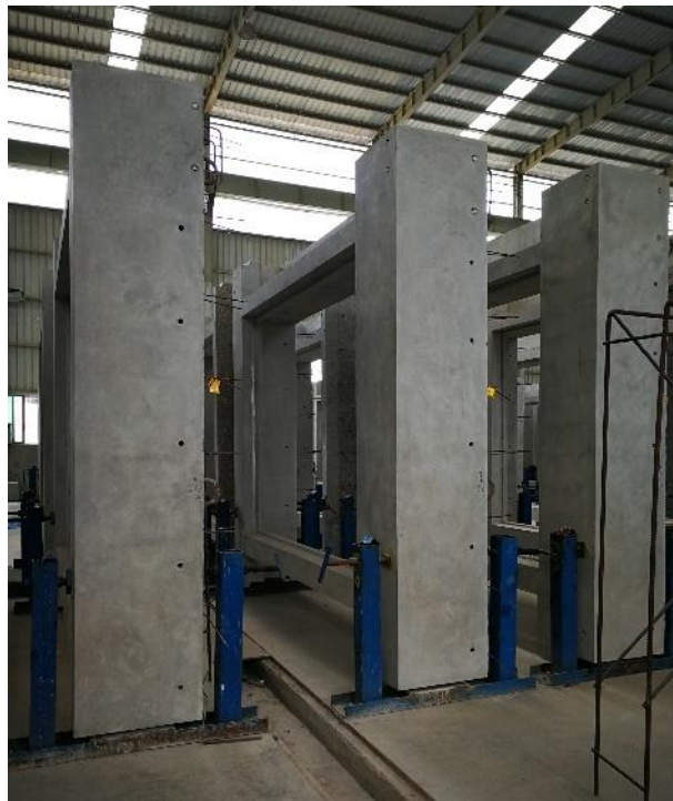
图 4-3-2 预制构件堆场正确堆放方式
