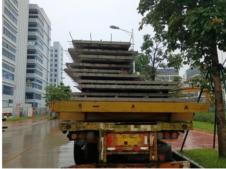
图 4-4-1 预制构件堆放重心偏位错误
