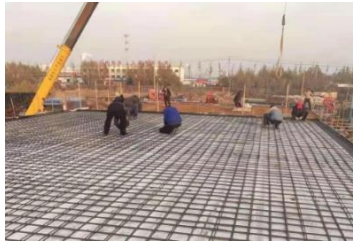
(7) 绑扎楼面钢筋及混凝土浇筑
