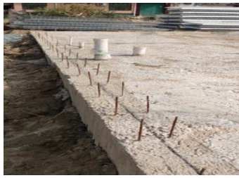
(2) 基础预留钢筋
