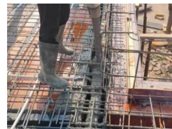
(8) 混凝土浇筑
